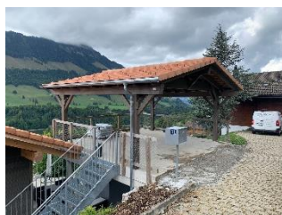
Toiture 2 pans « tuiles »
